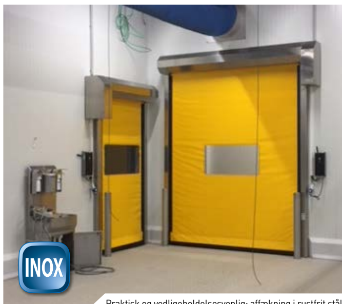
Praktisk og vedligeholdelsesvenlig: affækning i rustfrit stål
