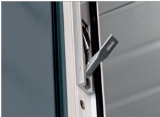
Kantrigel til låsning af den stående dørfløj (foroven og forneden)
